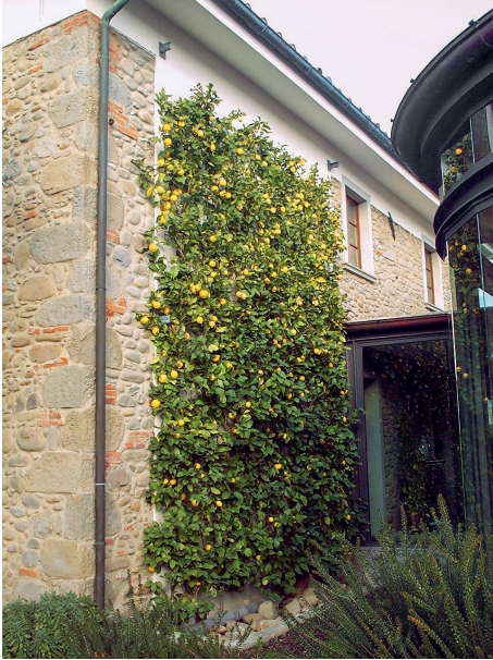
Fig. 6 La storica spalliera di limone, alla parete sud della casa colonica di famiglia, oggi sede degli uffici aziendali
