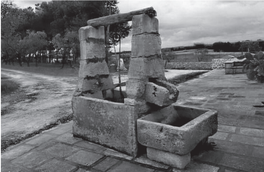
Fig. 1 Esempio di un pozzo per la raccolta di acqua piovana secondo una tradizione costruttiva della Puglia
