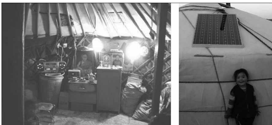
Fig. 12 Utenze di impianto autonomo 12 Vcc per le tende dei nomadi della Mongolia
