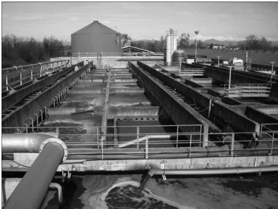
Fig. 10 Vasca di ossidazione di un impianto per la rimozione biologica dell'azoto
