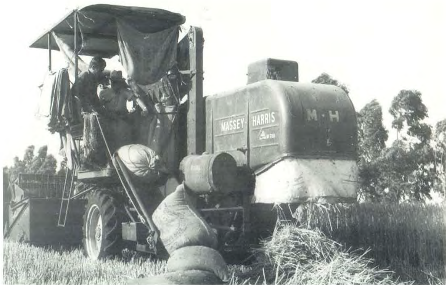
25 - Mietitrebbiatrice. Scarico dei sacchi sul campo
