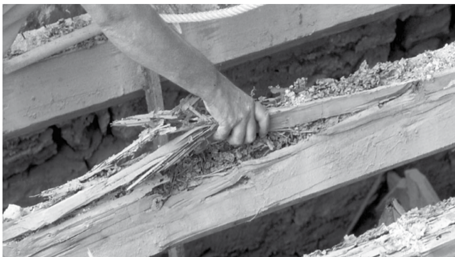
Attacchi termitici sulle strutture lignee delle coperture del Duomo di Monreale. All'esterno nessun segno di attacco
