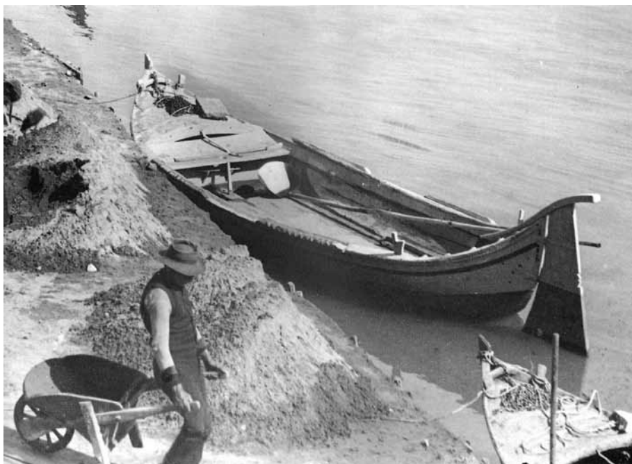
Fig. 4 Il barchino e il «palone» per sollevare la rena dal fondale; la sabbia, in mucchi, è poi trasportata con la carriola alla «piaggia» dove si provvede al vaglio (la fotografia di Emanuele Coucourde, «Arno oltre San Niccolò» , dei primi decenni del XX secolo, è tratta da Guerrini, 1990, p. 29)
