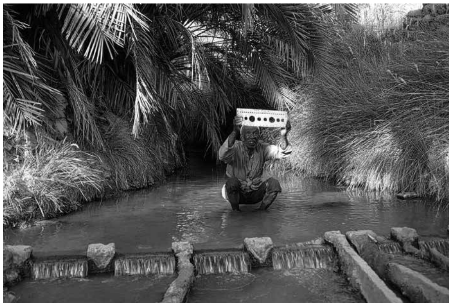
Foto 12 Il maestro dell'acqua con la piastra per la misurazione delle quote. Sahara, Algeria
