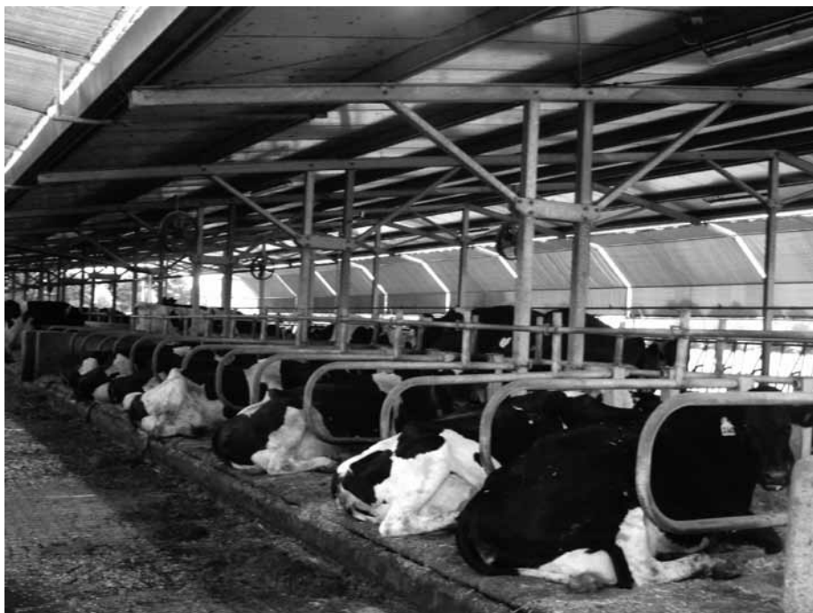
Fig. 9 Struttura bassa con copertura coibentata
