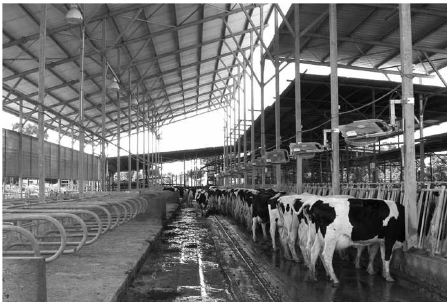
Fig. 16 Accumulo di acqua sul pavimento della zona di alimentazione dovuto all'utilizzo delle doccette
