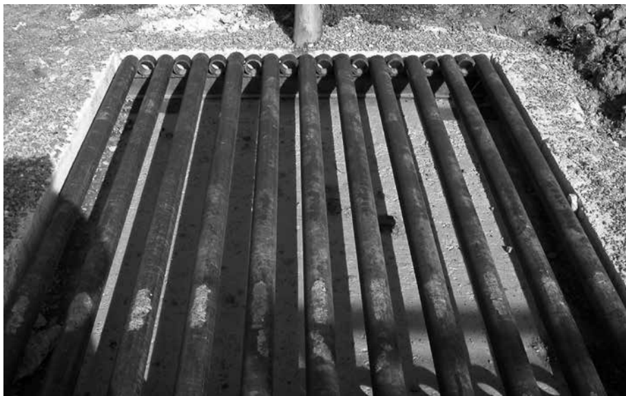
Fig. 6 Esempio di Cattle guard e schema costruttivo
