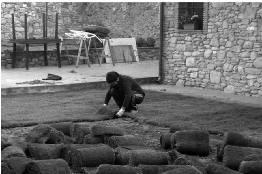
Fig. 4 Impiego di tappeto erboso in rotoli
