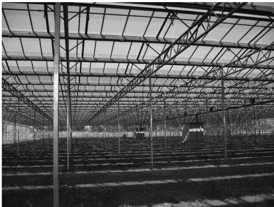
Fig. 6 Distribuzione dell'ombra in una serra in cui pannelli fotovoltaici sono installati sulla falda sud di ogni campata
