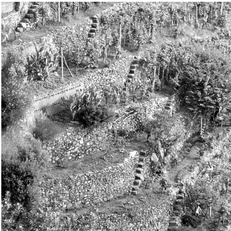
Fig. 6 Il sistema delle scale in pietra per l'attraversamento verticale dei terrazzi (Bagnara Calabra) (foto Di Fazio)
