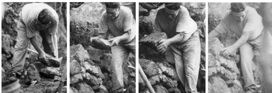
Fig. 7 Anziano artigiano al lavoro per la riparazione di un muretto a secco in un vigneto terrazzato di Bagnara Calabria (foto Di Fazio)
