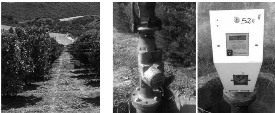
Fig. 1 Sinistra: la rottamazione impianti irrigui è stata sostenuta in Basilicata con una misura dedicata (DGR 2059/2001). Nella foto si noti la presenza dell'impianto irriguo sovrachioma sostituito con quello localizzato (tubi in PVC); destra: Sostituzione delle vecchie bocchette di erogazione (sinistra) con nuovi erogatori (destra) che consentono la contabilizzazione dei volumi irrigui prelevati operata in Consorzi irrigui della Basilicata (tratto da Xiloyannis et al., 2015)
