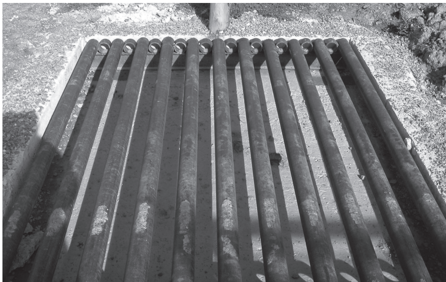
Fig. 6 Esempio di Cattle guard e schema costruttivo
